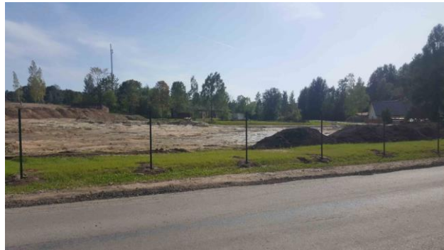
14.attēls Skats no Kalna ielas uz teritoriju
