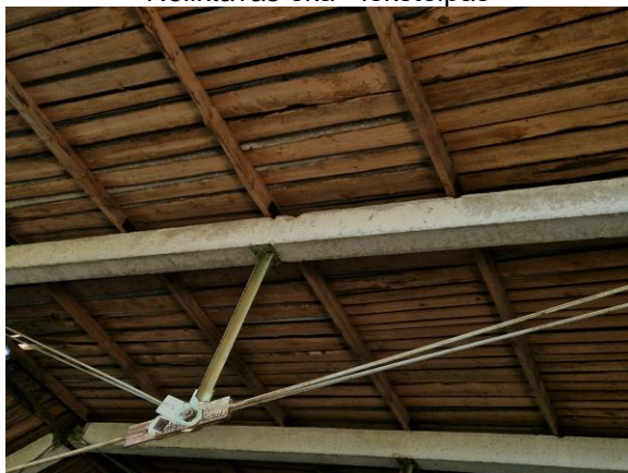
Noliktavas ēka – jumta konstrukcijas
